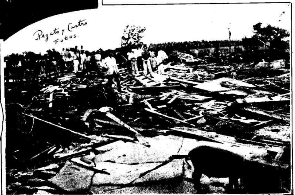
La fuerza del viento fué tan grande que quebró hasta la placa de concreto del piso...
