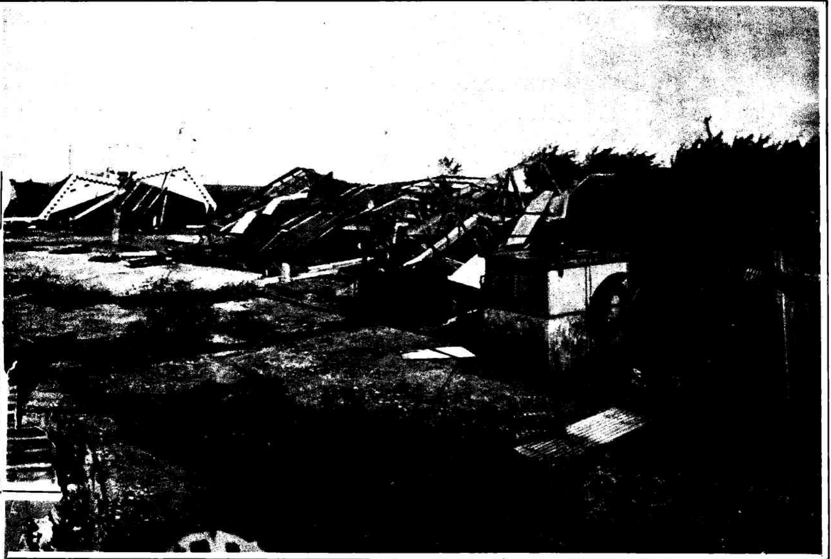
La casa de máquinas del central "Algodones", destruida por el meteoro.
