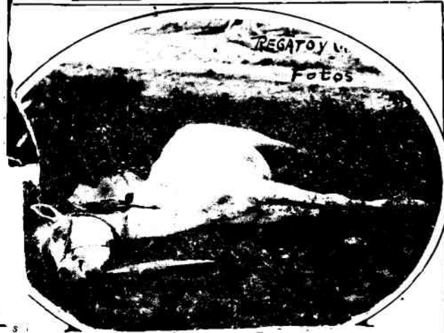
Un caballo electrocutado al caerle encima el tendido eléctrico de alta tensión.
